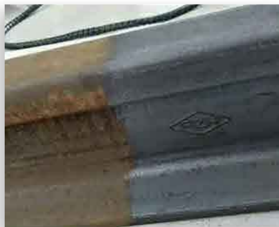
軌道除銹清洗
